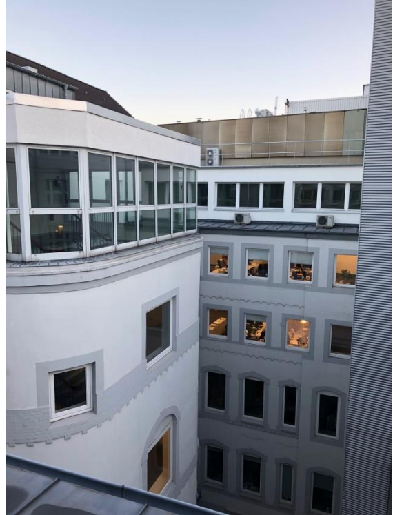
Fassadenflächen nach Sanierung
