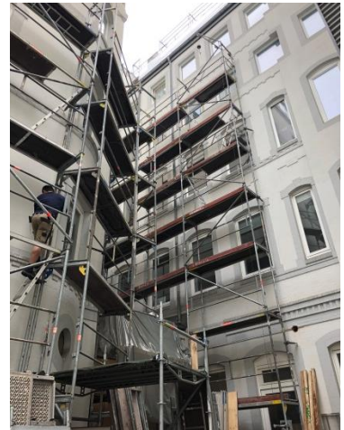
Gerüst im Innenhof
