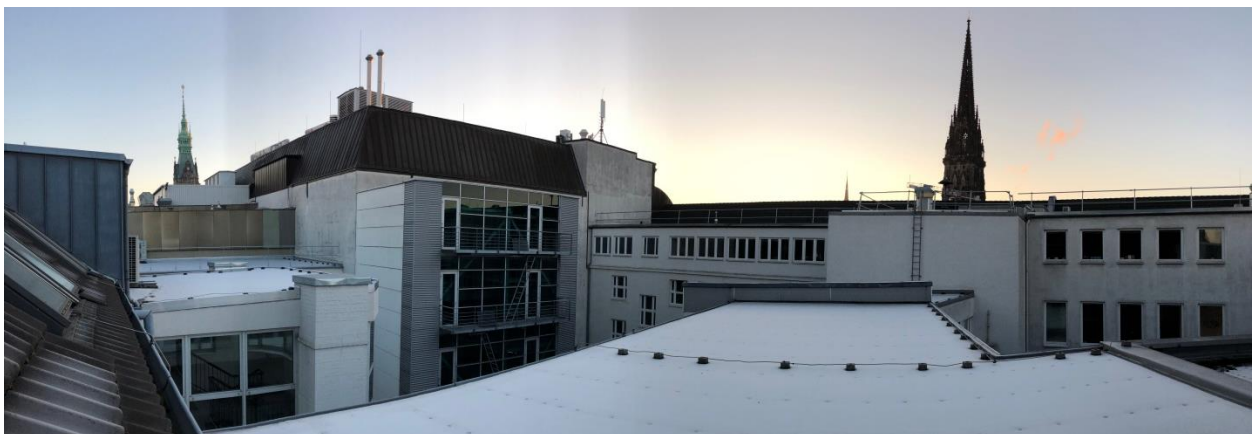
Dachfläche nach Sanierung
