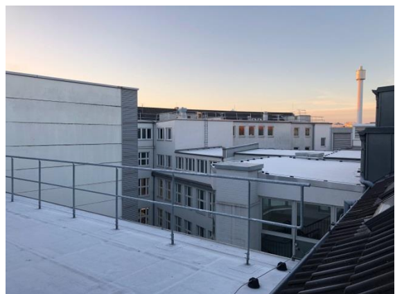
Metallgeländer als Absturzsicherung
