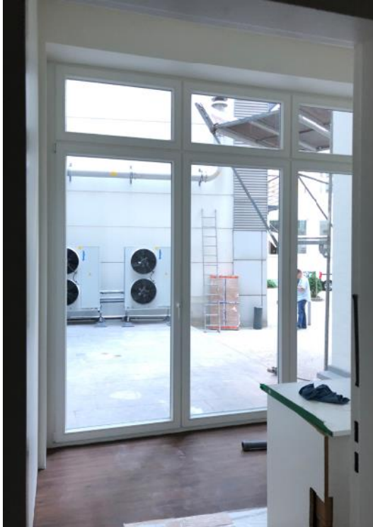
Neue Fensterelemente, die eine Revision des MRT-Gerätes ermöglichen
