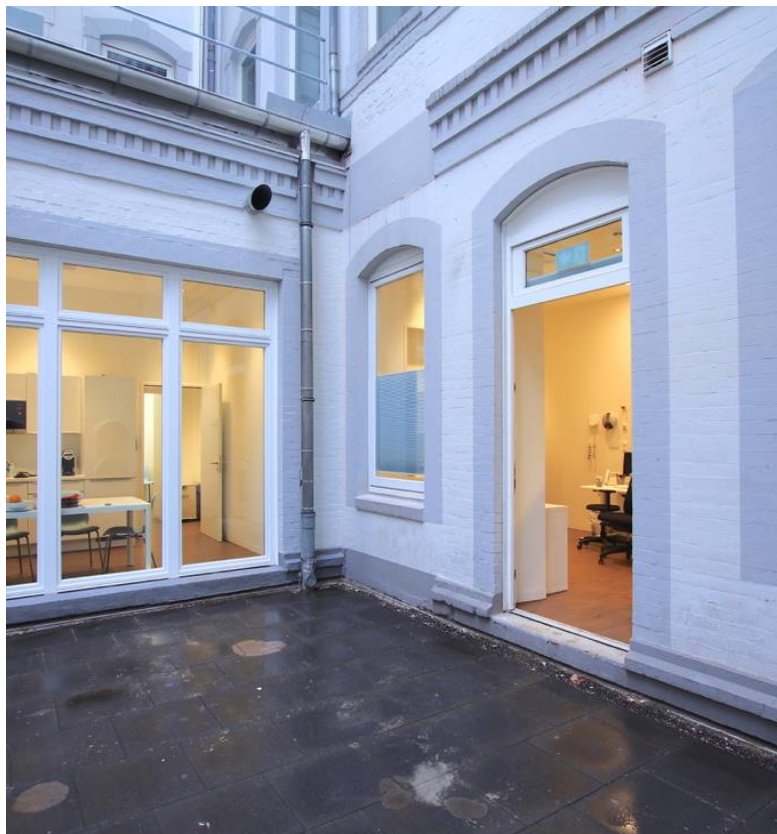
Fassadenansicht nach Abschluss der Arbeiten
