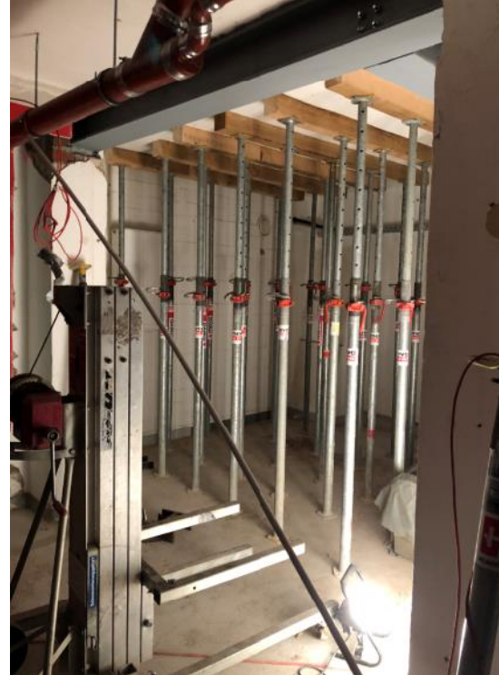
Temporäre Aussteifung bei Anlieferung des MRT-Geräts
