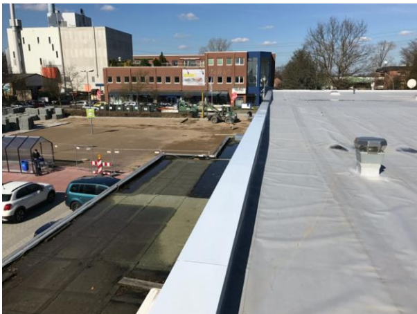
Dach mit neuer Entwässerung während der Sanierung im laufendem Betrieb
