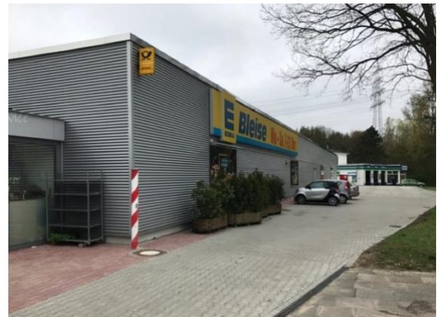
Neu hergerichteter Außenbereich und Gebäude mit neuer Attika.
