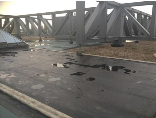
Dach vor Sanierung
