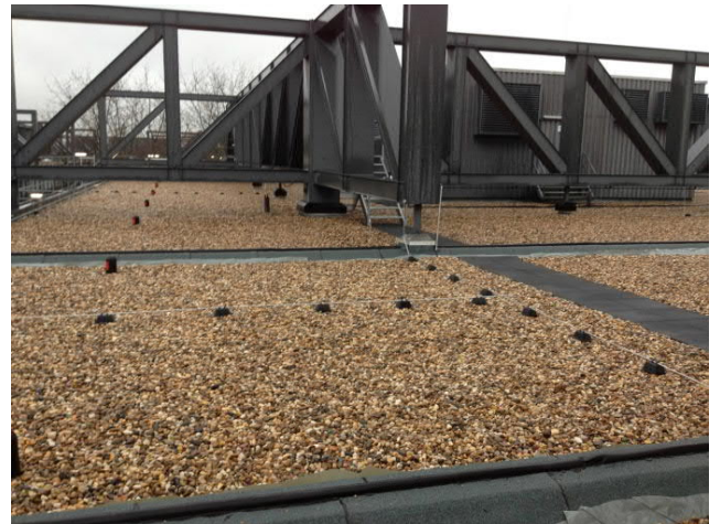
Dach nach Sanierung
