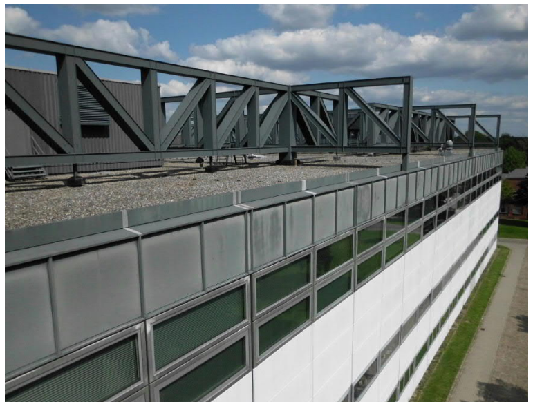
Gebäude vor Sanierung
